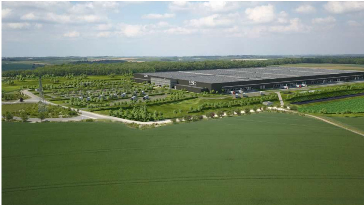
Figure 13 : vue aérienne sud-est/nord-ouest
