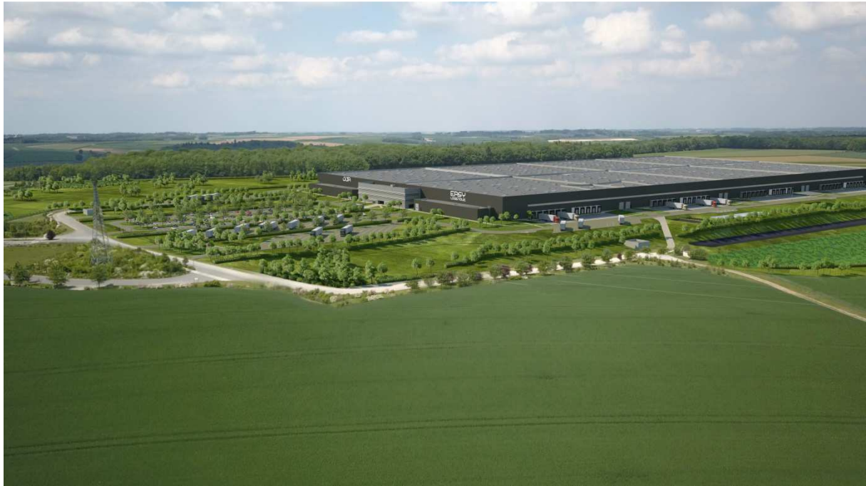
Figure 13 : vue aérienne sud-est/nord-ouest
