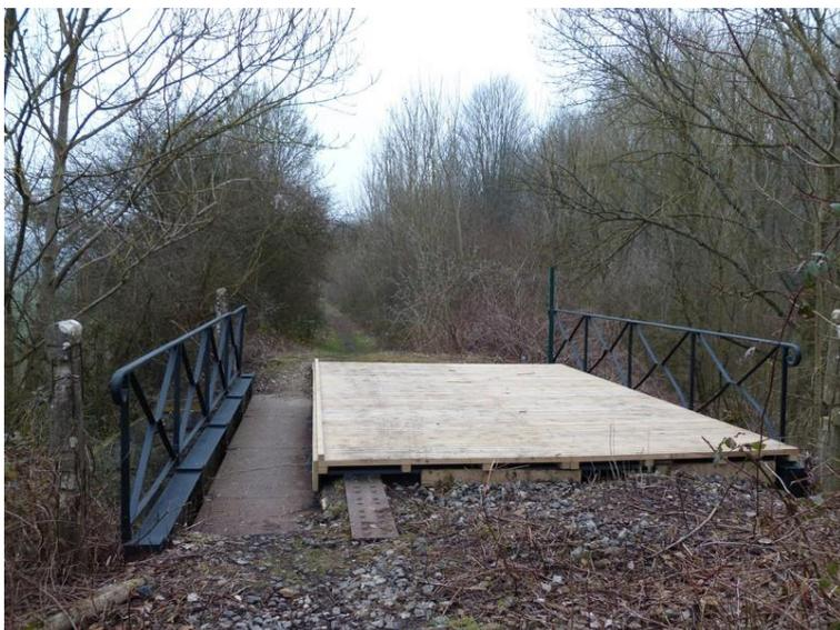
Le pont ferroviaire sécurisé par un plancher
