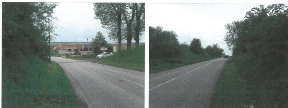
Vu depuis le talus côté gauche et droit en sortant de la parcelle.
