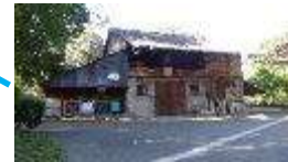
Bâtiment de stockage
