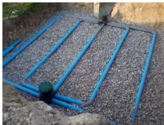
Ce contrôle consiste à vérifier lors des travaux et avant remblaiement que les éléments acceptés par le SPANC lors du contrôle de conception et que les réglementations en vigueur sont respectées. Il permet la délivrance d'un certificat de conformité.
