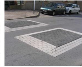
Le coussin peut être construit sur place. (Source : Cete de l'Est.)
