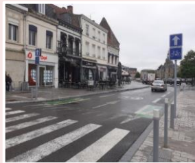
Dans des secteurs centraux, générateurs de flux piétons et motorisés, la zone 30 permet des aménagements qualitatifs pour les modes doux sans contraindre notablement le trafic motorisé
