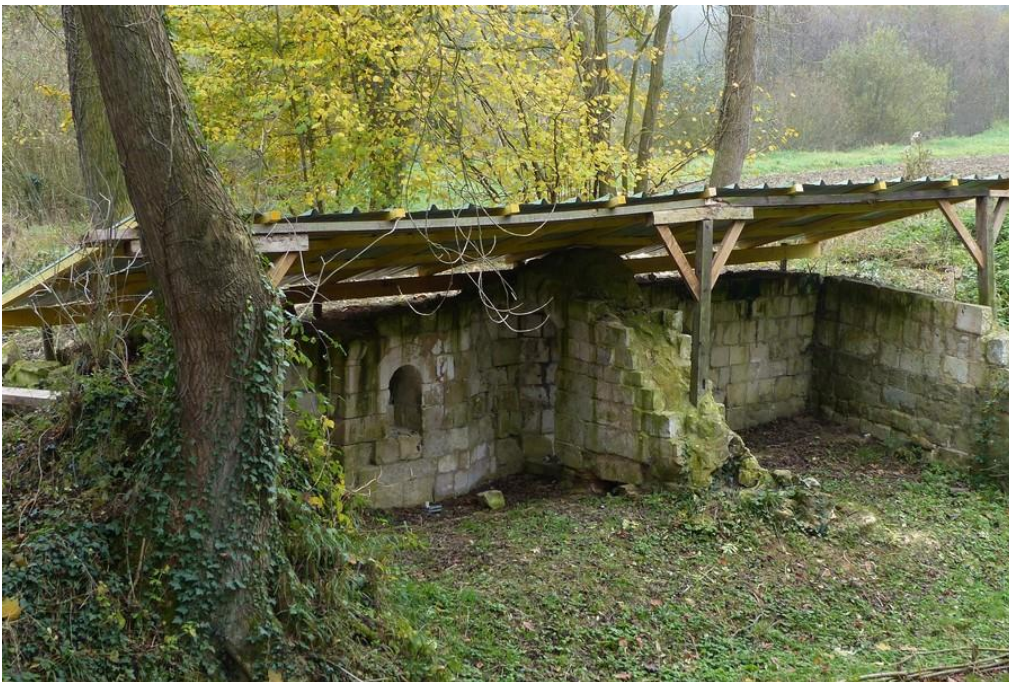
Les vestiges des bâtiments protégés par une couverture de tôle bac acier
