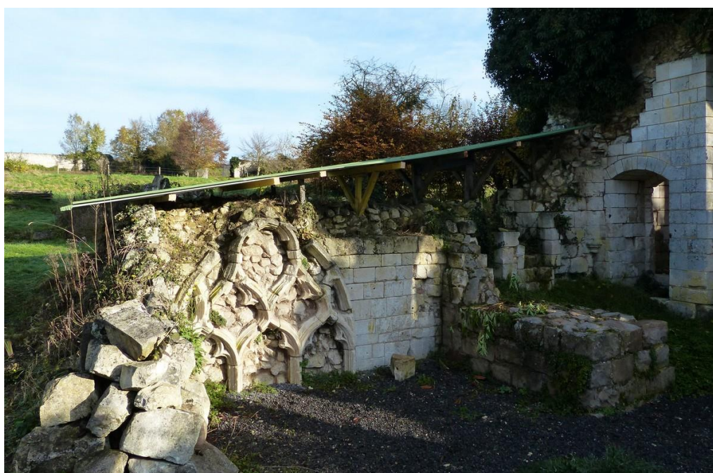
Le fenestrage protégé
