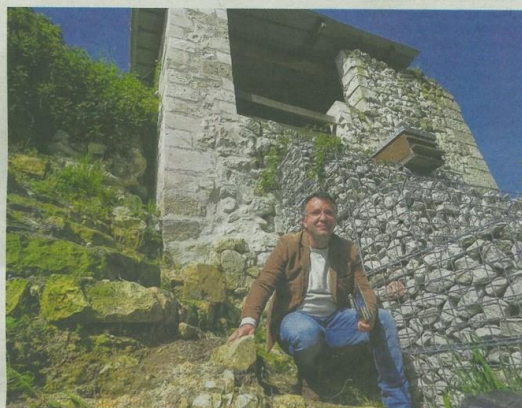
Sébastien Sireau a découvert un escalier au pied d'un mur qui vient d'être consolidé.
